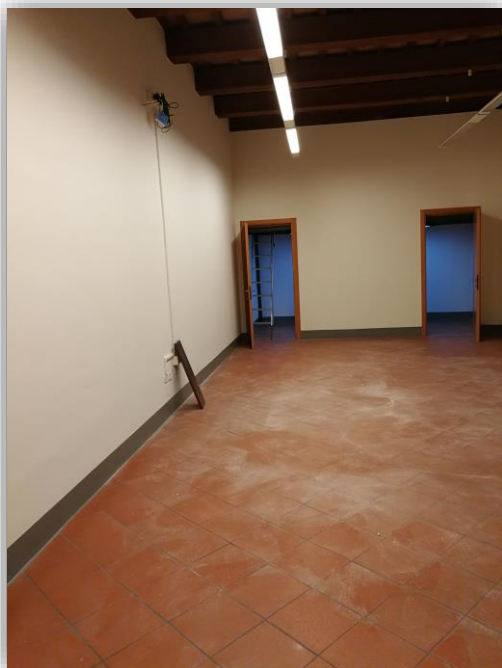
SALA 1 (lato sinistro)
